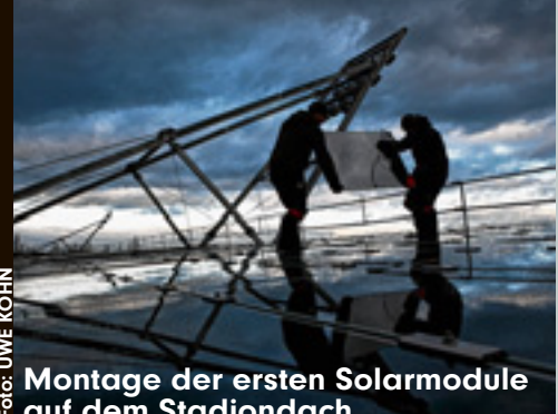
Montage der ersten Solarmodule auf dem Stadionsdach
