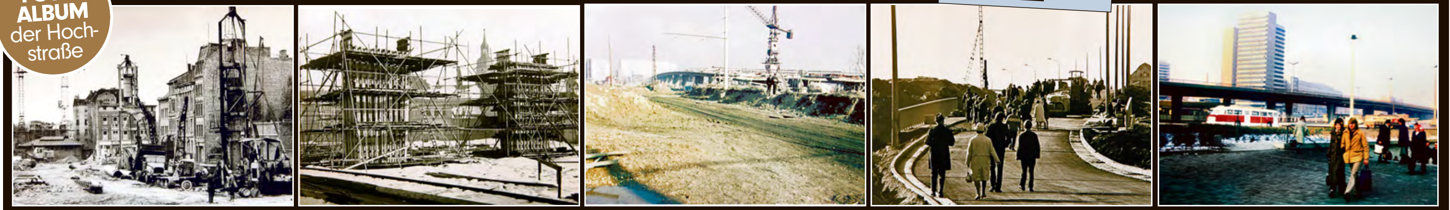
Die Hochstraße war schon einmal Tummelplatz neugieriger Fußgänger. Während der Errichtung von 1968 bis 1971 pilgerten Tausende Baustellentouristen zum „Kräne-Gucken“ an die drei Kilometer lange, vierspurige Trasse. Nicht alle Besucher waren gut gelaunt. Immerhin hatten für das Prestigeprojekt Dutzende historische Gebäude verschwinden müssen. Nach der Wende wurde die Kritik an der Hauptverbindung zwischen Alt- und Neustadt immer lauter. Eine Bürgerinitiative fordert den Totalabriss, die Stadt will sich zunächst von einem Strang trennen. Wie ein Leben ohne Hochstraße aussehen könnte, soll die Sperrung zur Party ergeben.
