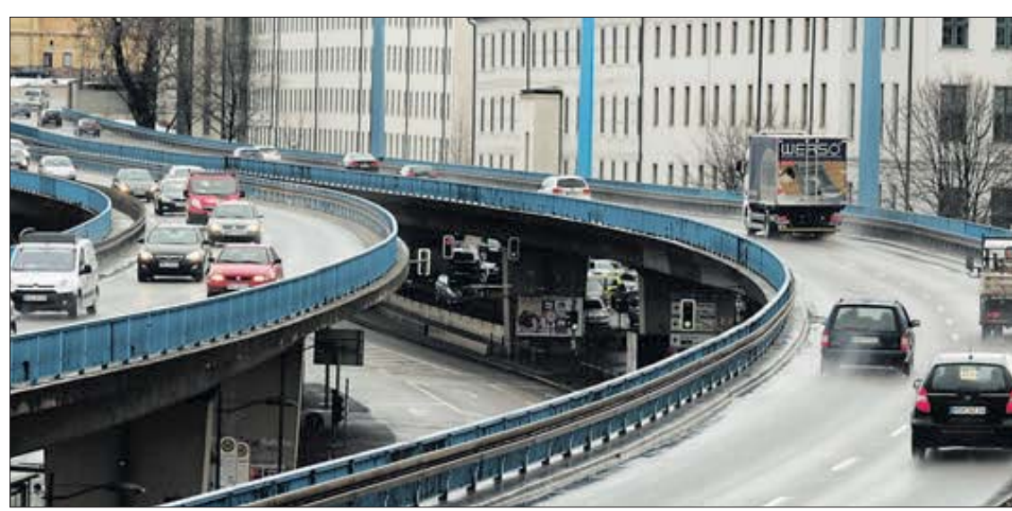
Fast 47 Millionen Euro kosten Halles Brücken in den nächsten zehn Jahren, hat die Stadtverwaltung errechnet. Zu den teuren Sorgenkindern gehört die Brücke über den Franckeplatz. Foto: Martin Schramme
